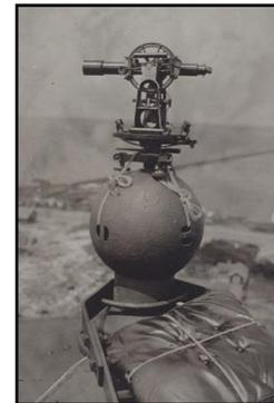
Figura 5. Teodolito montado en un tanque de agua [3].
